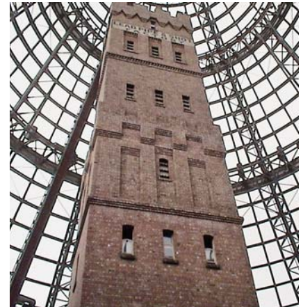
写真2 メルボルン・セントラルは都心のショッピングセンターで、かつて鉛の玉を製造した歴史的建造物ショットタワーを取り込むために、高さ84mのガラスの尖塔までつくった。(2010年9月)
